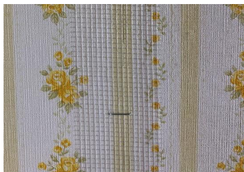
ジョイントテープとタッカーの処理
