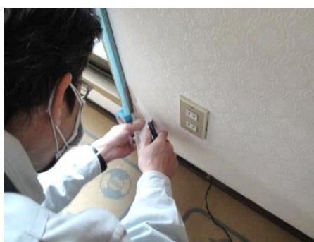
ビニールクロスの補修
